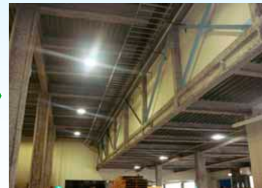
設置後 (LED照明)
