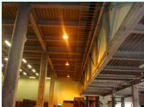
設置前 (既存のナトリウム灯)
