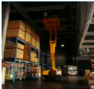
作業中(高所作業車使用)
